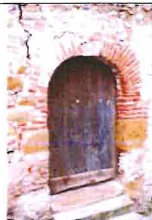
Exemples de mur en silex et ouverture en briques chantignoles : 6, rue de la Chevrotterie
