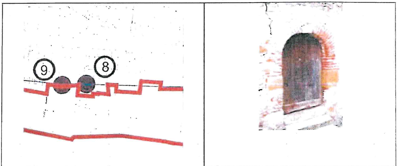
Ouverture en ogive avec briques - pierres de Maray - pierre de Beauce et silex : 3, rue de la Chevrotterie
